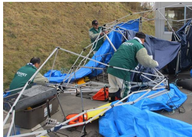
<9:30> 作業開始。 まずは、強風で倒れたテントの撤去作業
